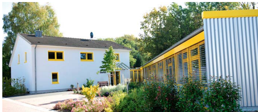
Der Hauptsitz der Steffel KKS GmbH befindet sich im niedersächsischen Lachendorf bei Celle. Seit der Ansiedlung im Jahr 1989 ist hier eine Art Innovationszentrale für den Kathodischen Korrosionsschutz in Deutschland entstanden.
